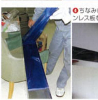
④ちなみに天井側の傷口はミガキのステンレス板を張り込んだ。曲げはプロに依頼。
