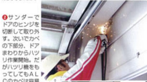
②サンダーでドアのヒンジを切断して取り外す。次いでカベの下部、ドアまわりからハツリ作業開始。だがハツリ機をもってしてもALCのカベは容易に倒れない(作業をしているのはハツリ機を貸してくれた建築屋さん)。
