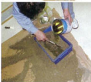
②そこでモルタル・コンクリート用エポキシ接着剤(コニシボンド製)に砂を混ぜて塗ってみた。容器に砂を取って接着剤と硬化剤を投入。よく混ぜて傷口に塗り込んでいく。
