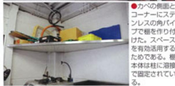
●カベの側面とコーナーにステンレスの角パイプで棚を作り付けた。スペースを有効活用するためである。棚本体は柱に溶接で固定されている。
