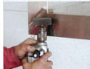
●製作方法はやや変わっていて、まず土台の直角部分をレベルを出しながら柱に固定し、建物の形状に合わせてTIG溶接機で立ち上げた。組み付け後、研磨パフでヘアラインを入れている。
