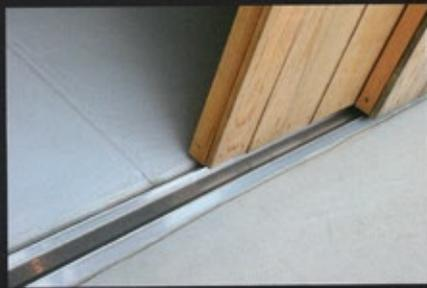
正面の引き戸のレールは、1枚の厚さ2.2mmのステンレス板を曲げて作った力作。そのかいあって、扉を開く際もスムーズに動かせるそうだ。
