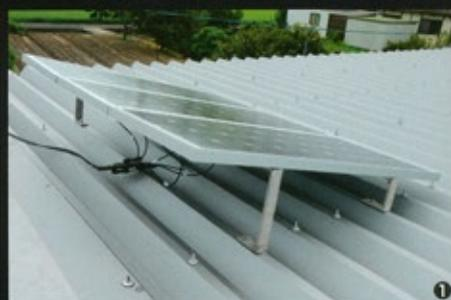
①屋根に取り付けた太陽光パネルは300Wのタイプ。②太陽光パネルで発電した電気を、バッテリーに充電するためのチャージコントローラー。当初は20アンペアだったが、容量が足りないため30アンペアに変更したそうだ。③壁に取り付けたチャージコントローラーから大容量バッテリーに接続して充電。バッテリーから電球やエアコン、換気扇に配線し、24時間換気もOK。
